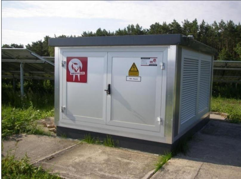
**Abb. 25:** Beispiel für einen Transformator, der den Wechselstrom von 400 V auf 20 KV hochtransformiert (hier PVA „Alte Poststraße“) Friesack, Zootzen).
