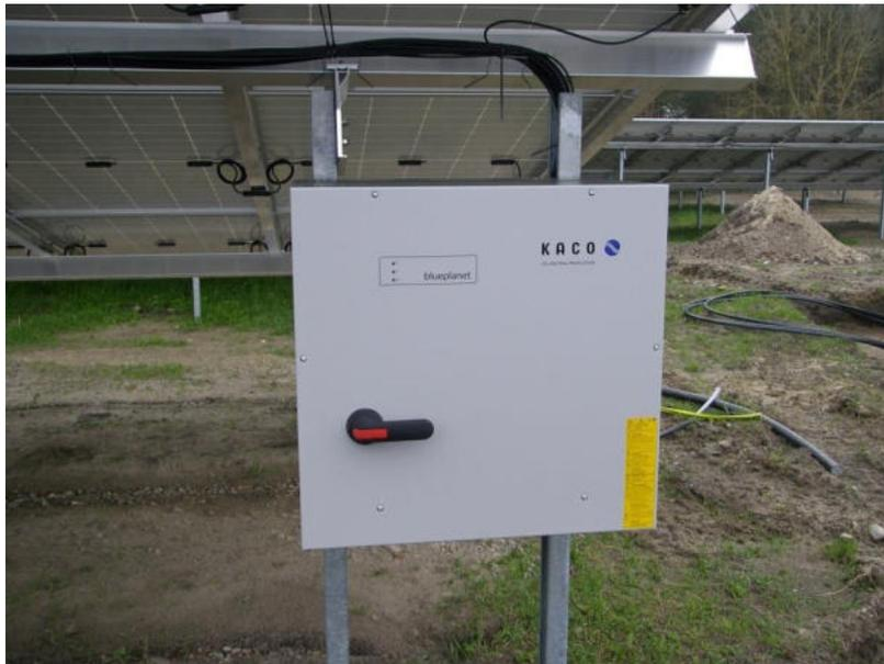
**Abb. 24:** Beispiel für einen unter den Modultischen stehenden Stringwechselrichter (hier PVA „Alte Poststraße“ Friesack, Zootzen). (Foto RIK: P1010014\_2023-04-18)
