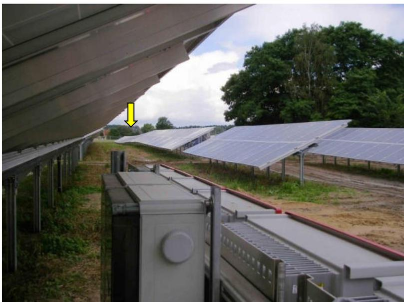
**Abb. 31:** Beispiel aus dem Solarpark Kremmen für die höhenmäßige Anpassung der Modulreihen an das Gelände. Der Pfeil zeigt eine Verwerfung, die für die Funktionstüchtigkeit der Photovoltaikmodule ohne Bedeutung ist.
