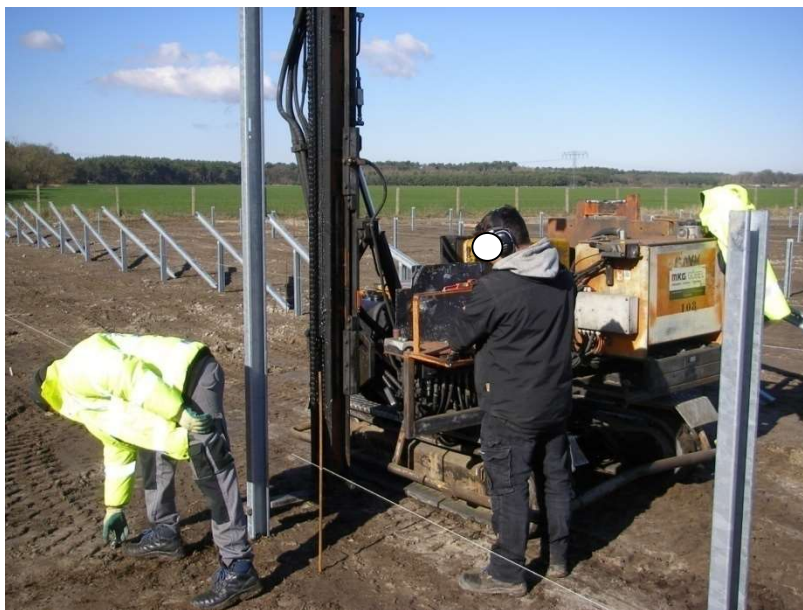
Abb. 19: Die Ramntechnologie der Modultische (hier PVA „Alte Poststraße“ Friesack, OT Zootzen). (Foto RIK: P1010011.JPG)
