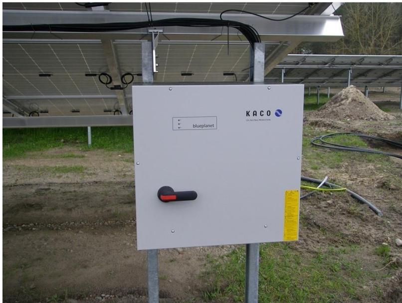
**Abb. 7:** Beispiel für einen unter den Modultischen stehenden Stringwechselrichter (hier PVA „Alte Poststraße“ Friesack, Zootzen).
