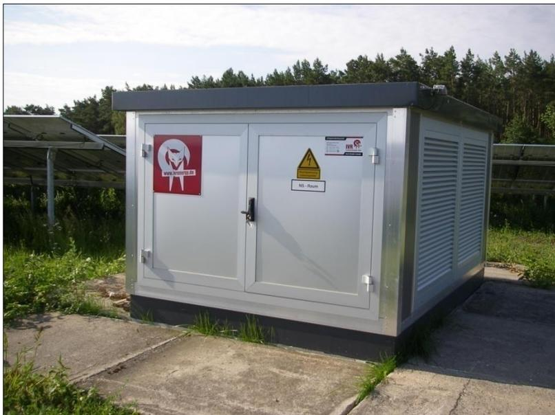
**Abb. 8:** Beispiel für einen Transformator, der den Wechselstrom von 400 V auf 20 KV hochtransformiert (hier PVA „Alte Poststraße“ Friesack, Zootzen).
