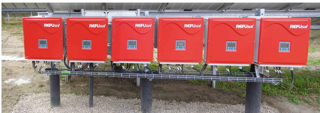
**Abb. 10:** Beispiel für eine unter den Modultischen stehende Wechselrichteranlage aus sechs einzelnen Wechselrichtern, hier Solarpark Kremmen.
