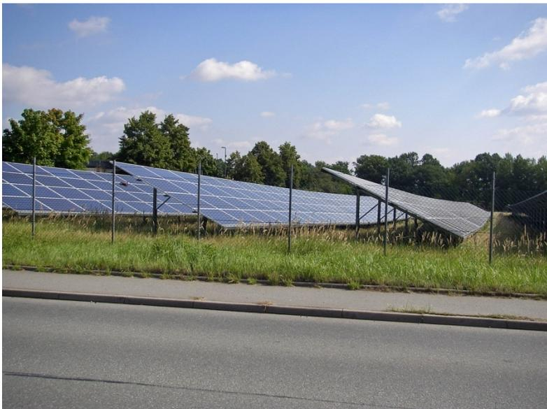
**Abb. 18:** Beispiel für Modulreihen einer Freiflächen-Photovoltaik-Anlage (hier Solarpark Bautzen) wie sie für die PV-Anlage an der Alten Poststraße zum Einsatz kommen soll.
