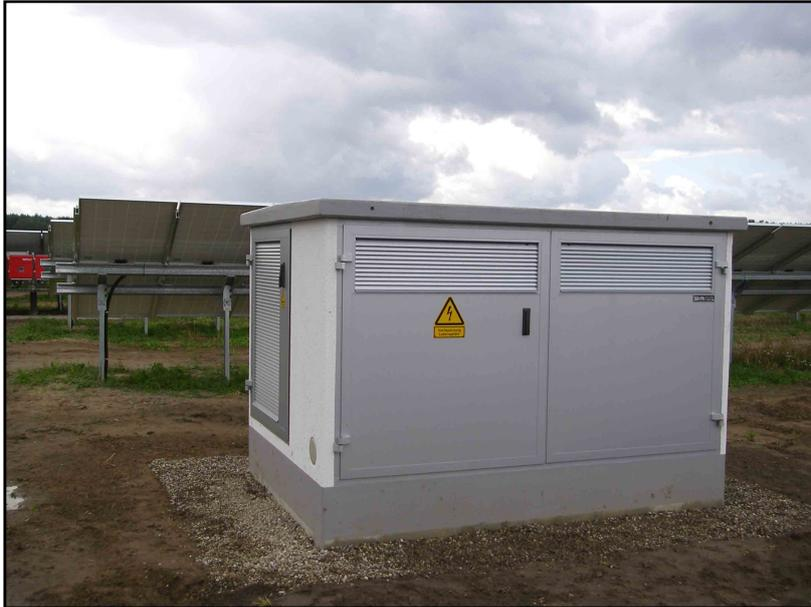
**Abb. 22:** Beispiel für einen Transformator, der den Wechselstrom von 400 V auf 20 KV hochtransformiert, hier Solarpark Kremmen.
