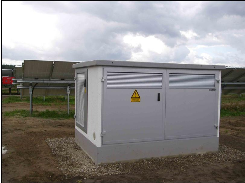
**Abb. 11:** Beispiel für einen Transformator, der den Wechselstrom von 400 V auf 20 KV hochtransformiert, hier Solarpark Kremmen.
