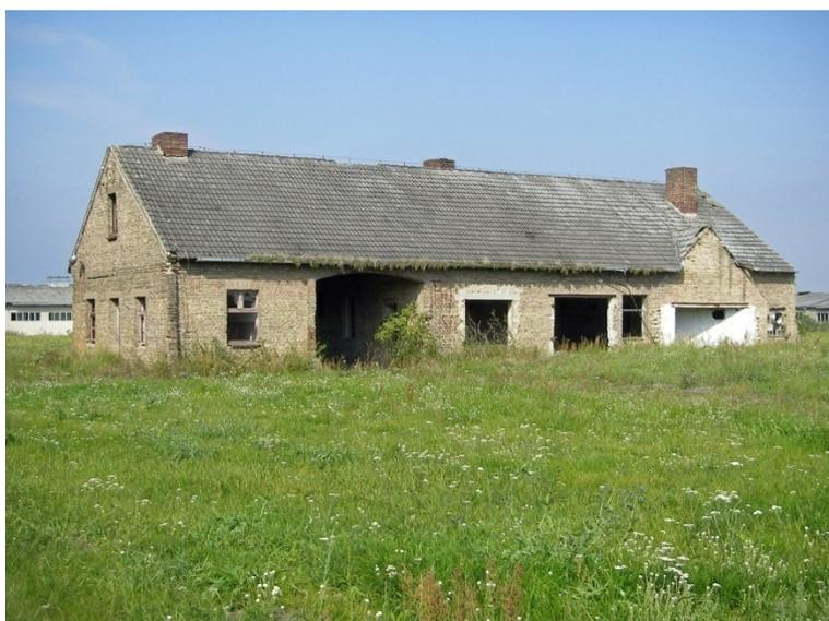
**Abb. 28:** Das ehemalige Futterhaus als Beispiel für die marode und verschlissene Bausubstanz in der stillgelegten Schweinemastanlage.
