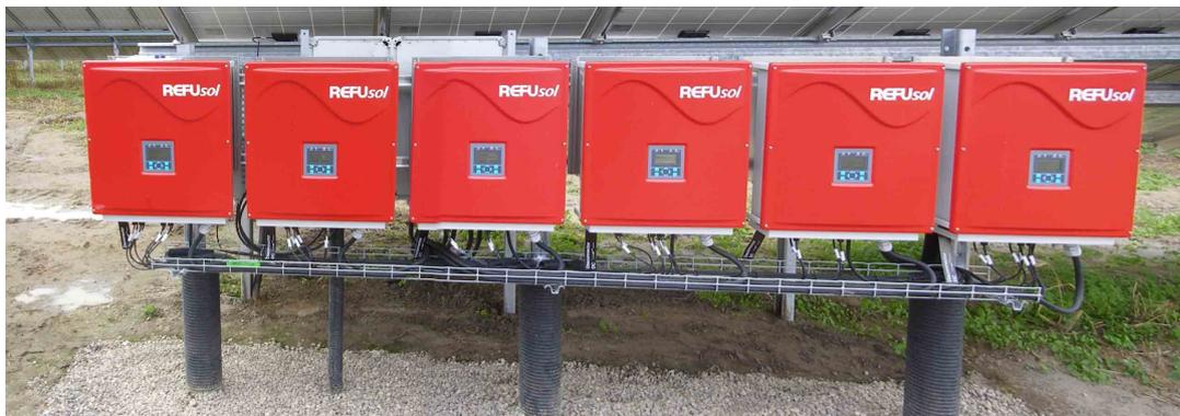
**Abb. 21:** Beispiel für eine unter den Modultischen stehende Wechselrichteranlage aus sechs einzelnen Wechselrichtern, hier Solarpark Kremmen.
