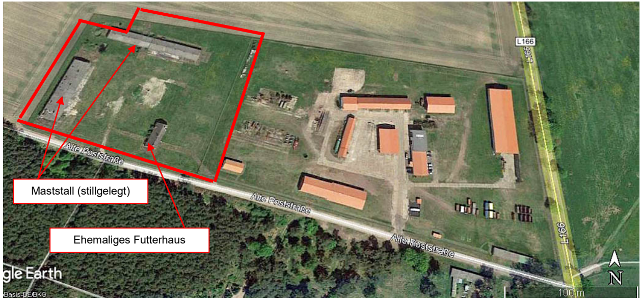
Abb. 13: Satellitenaufnahme des Betriebsgeländes der Agrargenossenschaft Wutzetz mit der stillgelegten Schweinemastanlage (rote Umgrenzung) und dem sich östlich angrenzenden Betriebsgelände mit den neu eingedeckten Gebäuden. Das Satellitenbild verdeutlicht die Inanspruchnahme von nicht mehr benötigten Freiflächen der Agrargenossenschaft. Diese Flächen stellen im Sinne des EEG 4 typische Konversionsflächen dar. (Quelle: Google)
