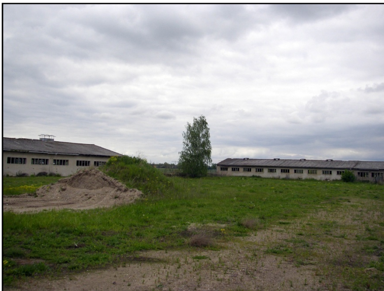
Abb. 27: Erdstoff- bzw. Kieshaufen im Gelände der stillgelegten Schweinemastanlage. (Foto RIK: P 1010003.JPG)
