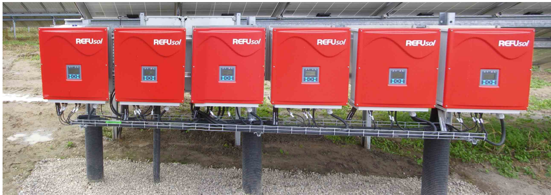
Abb. 17: Beispiel für eine unter den Modultischen stehende Wechselrichteranlage aus sechs einzelnen Wechselrichtern, hier Solarpark Kremmen. (Foto RIK: P7120004-05)
