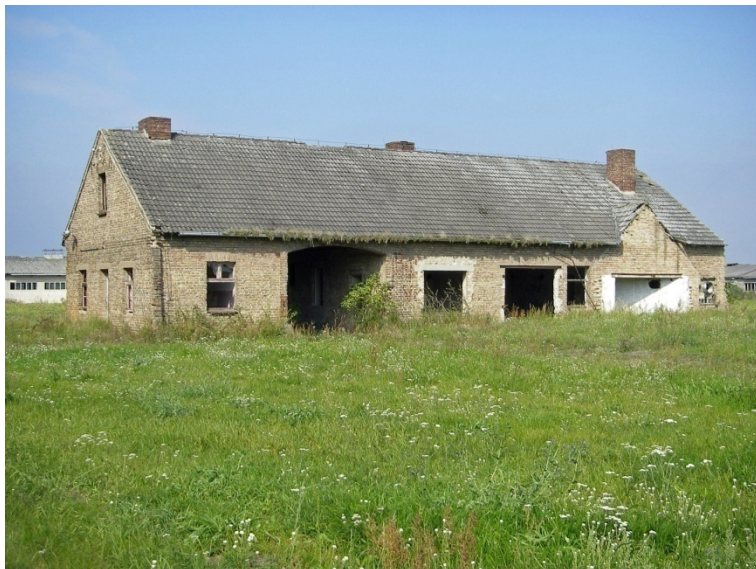
Abb. 26: Das ehemalige Futterhaus als Beispiel für die marode und verschlissene Bausubstanz in der stillgelegten Schweinemastanlage. (Foto RIK: P 10100“.JPG_2021-09-10)
