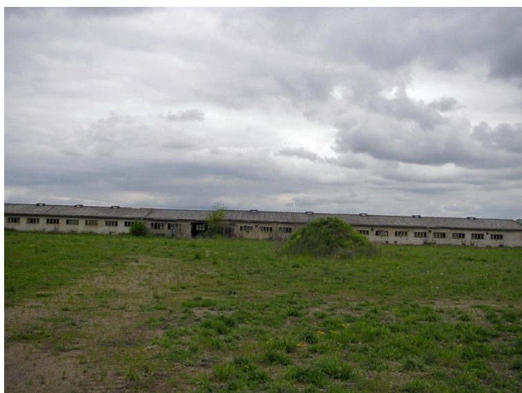
Abb. 8: Blick in das Plangebiet mit dem Biotop (03421) Künstlich begründete Gras- und Staudenflur . Trotz Stilllegung der Schweinemastanlage sind noch eine Vielzahl von Fahrspuren sichtbar. (Foto RIK: P 1010005.JPG_2021-05-18)
