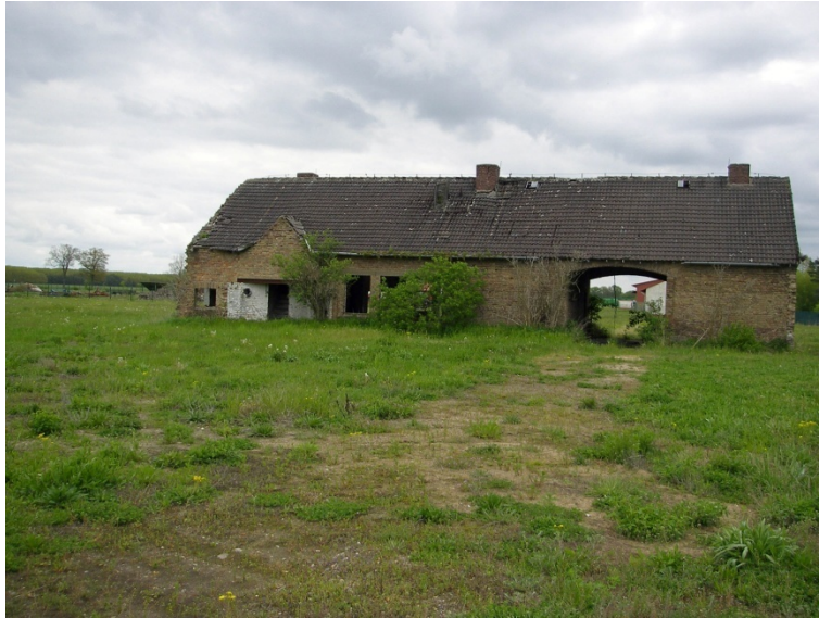
Abb. 9: Das ehemalige Futterhaus als Beispiel für die marode und verschlissene Bausubstanz in der stillgelegten Schweinemastanlage. (Foto RIK: P 1010008.JPG_2021-05-18)
