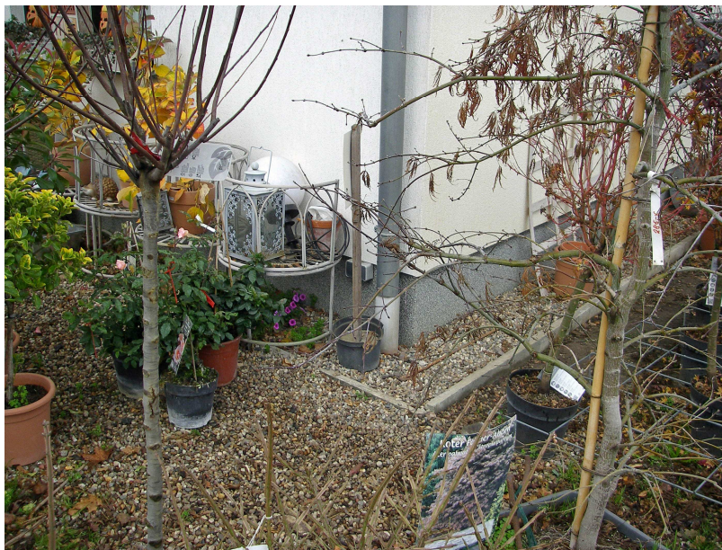
Abb. 22: Direkteinleitung der Dachflächenentwässerung in eine Rohrrigole, hier die Südostecke des Büro- und Sozialgebäudes. (Foto RIK: P1010020.JPG)
