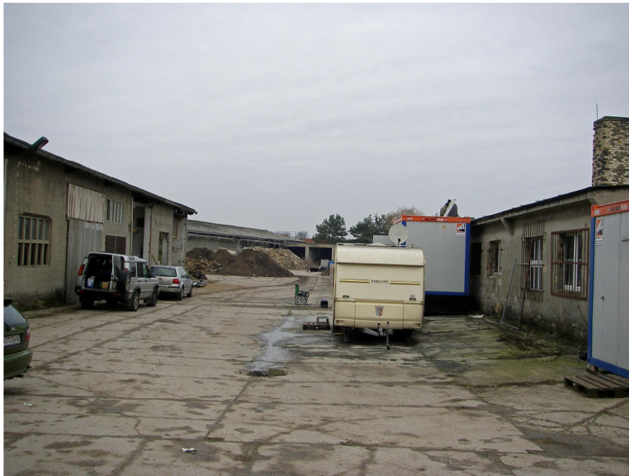
Abb. 10: Beispiel für die Befestigung der Verkehrswege mit Straßenbeton. (Foto RIK: P131216-021.JPG)
