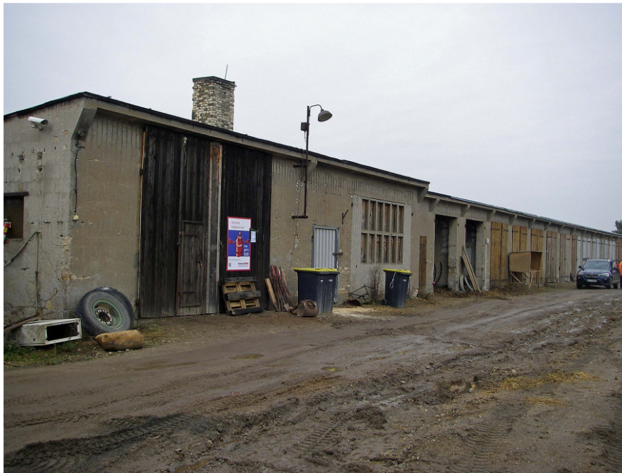
Abb. 9: Beispiel für die vorhandene Bausubstanz im Plangebiet des vorhabenbezogenen Bebauungsplanes. Die Gebäude sind alle stark verschlissen. Hier Blick auf die Lagerhalle im Baufeld 3. (Foto RIK: P131216-016.JPG)
