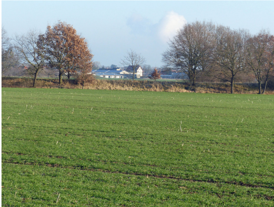
Abb. 21: Blick auf den Gebäudekomplex des Plangebiets aus südwestlicher Richtung. Hier wird deutlich, wie die großvolumige Ortsrandbebauung des ehemaligen Technikstützpunktes durch eine intensive Eingrünung gemildert werden kann. (Foto Pfeifer: 03)
