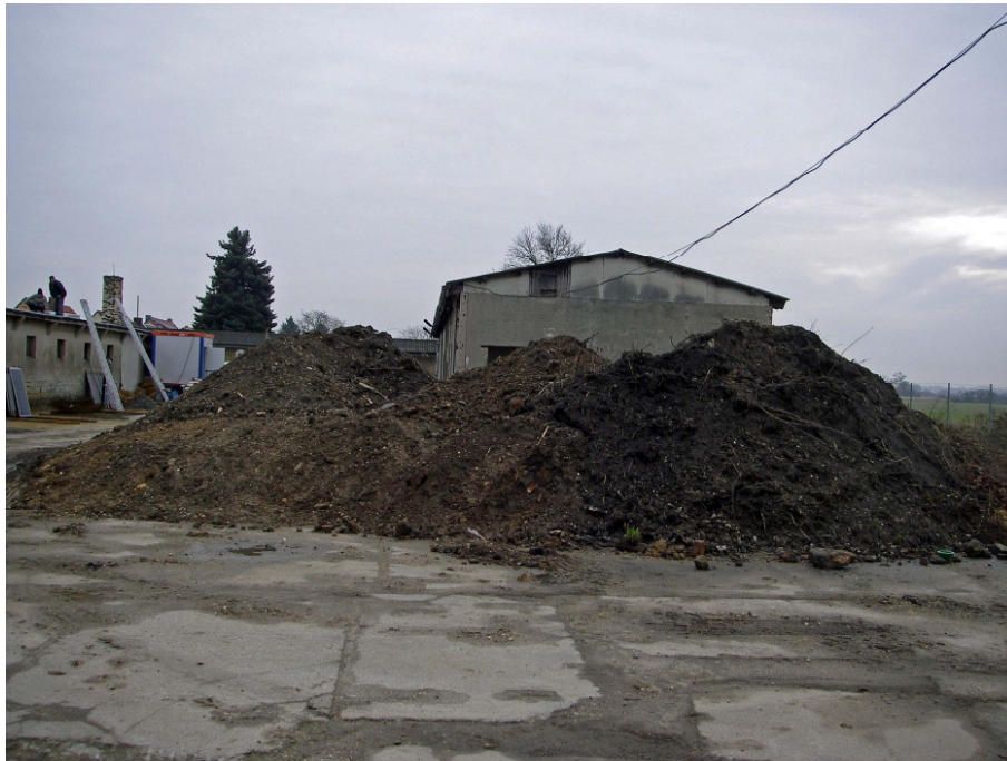
Abb. 12: Beispiel für abgelagerte Erdstoffe, hier am Nordgiebel der Lagerhalle (Baufeld 3). Die Erdstoffe sind Aushubmaterialien, die wieder verwendet werden. (Foto RIK: P131216-045)
