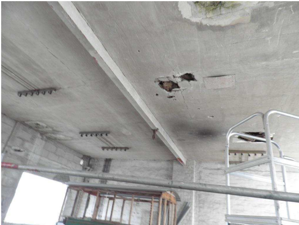
Bild 13: Blick auf desolate Zwischendecke in Lagerhalle im Westteil des Plangebiets
