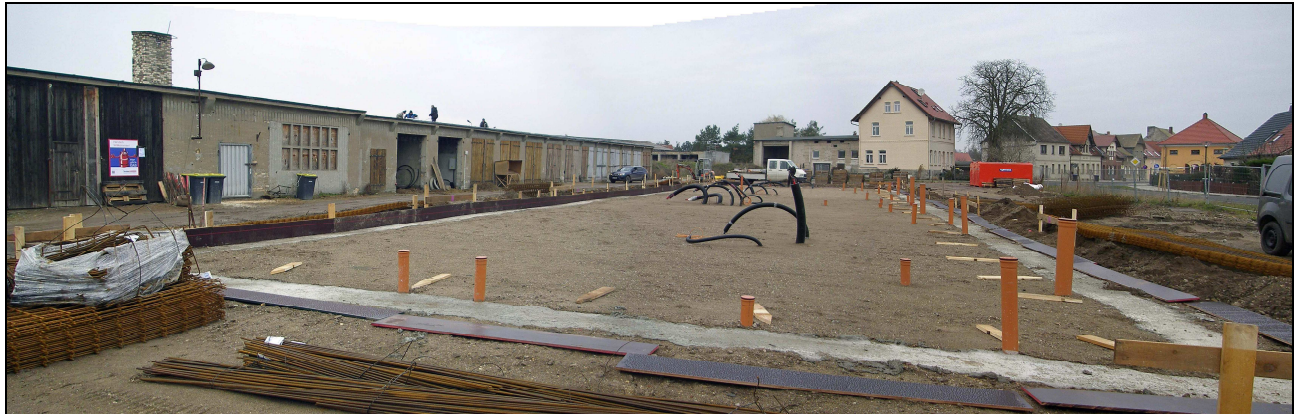
Bild 15: Blick nach Norden über die Bausteller für das altersgerechte Wohnen um zentralen Bereich des Plangebiets
