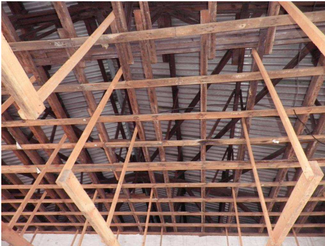
Bild 11: Blick auf Dachkonstruktion in Lagerhalle im Westteil des Plangebiets
