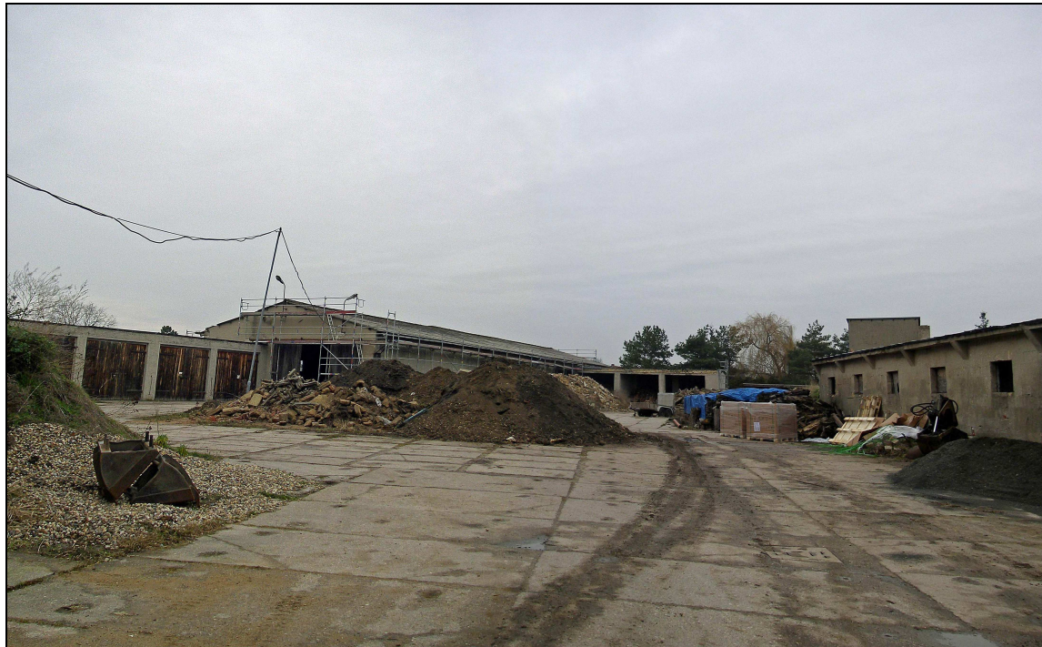
Bild 6: Blick von Süden auf die Mehrzweckhalle im Nordteil des Plangebiets
