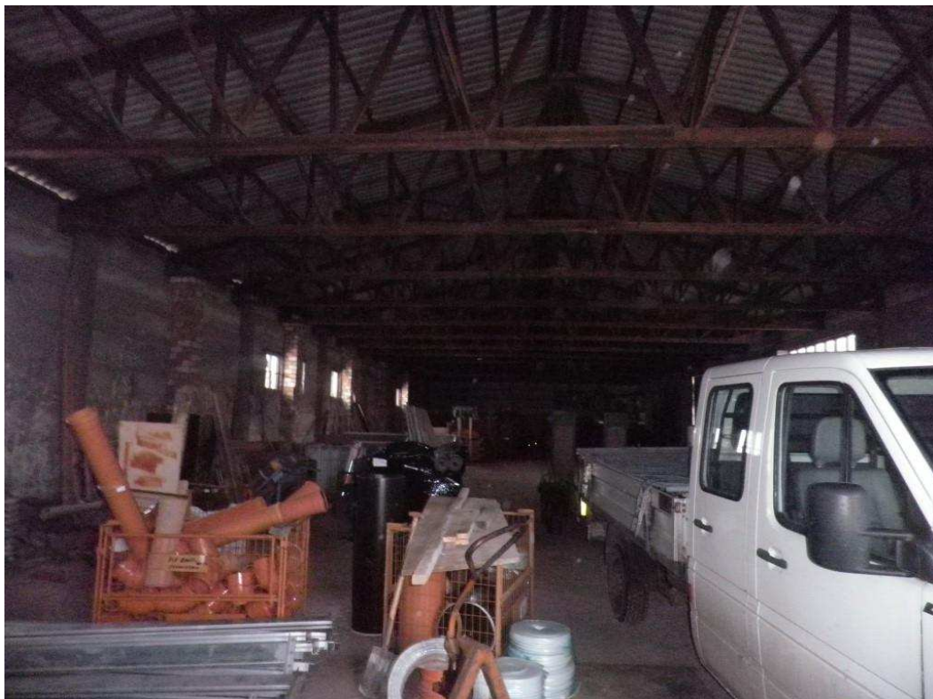
Bild 14: Blick in Mehrzweckhalle im Nordwestteil des Plangebiets
