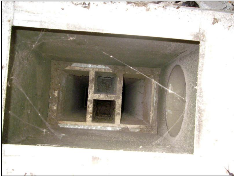
**Abb. 13:** Blick in einen geöffneten Entlüftungsschacht, rechts ist das Ansaugrohr des maschinellen Elektrolüfters sichtbar.
