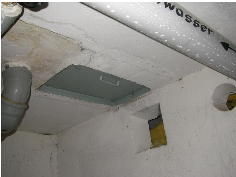
**Abb. 12:** Das Schwerkraftsystem der Schachtlüftungen wurde im Kellergeschoss durch Blechplatten verschlossen.
