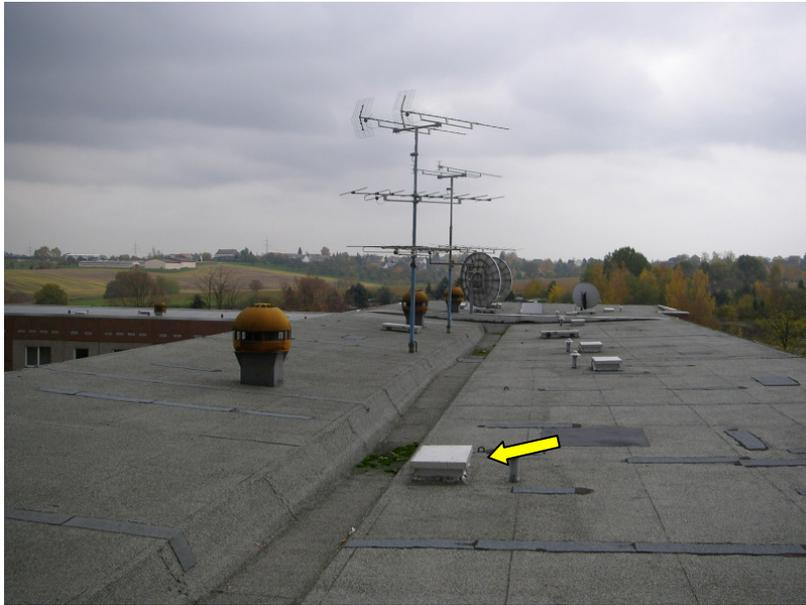
**Abb. 11:** Die Dachfläche des Wohnblocks *Wettiner Ring 39/41a* mit den maschinellen Elektrolüftern. Die ursprünglichen Schachttöffnungen der Schwerkraftlüftung (siehe Pfeil) wurden durch Blechhauben verschlossen.
