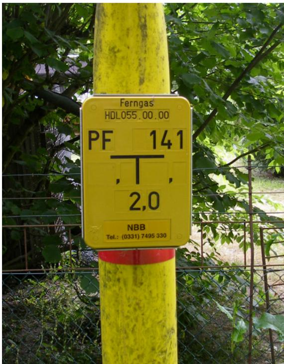
**Abb. 21:** Gassäule die den Verlauf einer Ferngasleitung entlang des westlichen, unbefestigten Weges markiert.
