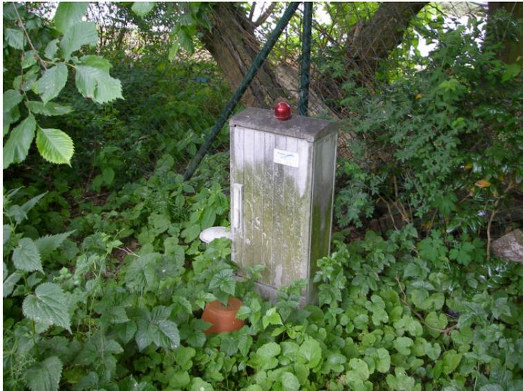
**Abb. 20:** Schaltkasten mit Warnleuchte an der Südgrenze des Plangebietes zur Steuerung der Schmutzwasseranlage des Hauses *Amselsteig 1*.
