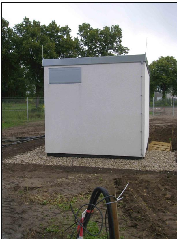
**Abb. 8:** Beispiel für eine Mittelspannungsschaltstation 20 KV, hier Solarpark Kremmen.
