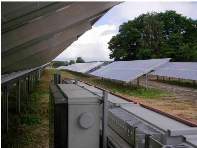
**Abb. 5:** Unterkonstruktion der Photovoltaik-Module mit nur einer Mittelstütze, hier Solarpark Kremmen. (Foto RIK: P7120009)
