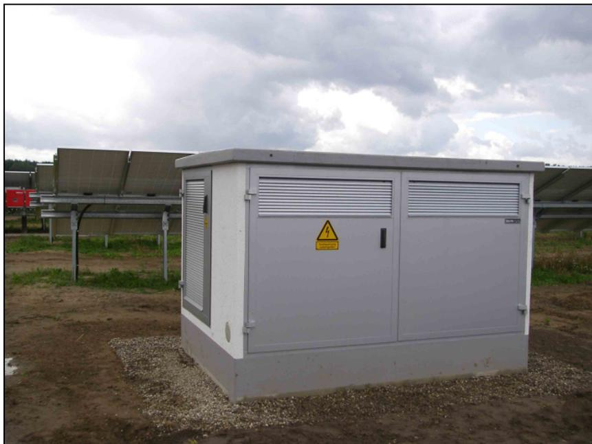
**Abb. 7:** Beispiel für einen Transformator, der den Wechselstrom von 400 V auf 20 KV hochtransformiert, hier Solarpark Kremmen.
