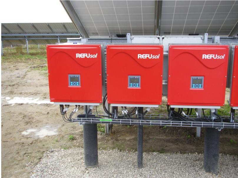
**Abb. 6:** Beispiel für eine unter den Modultischen stehende Wechselrichteranlage aus sechs einzelnen Wechselrichtern, hier Solarpark Kremmen.
