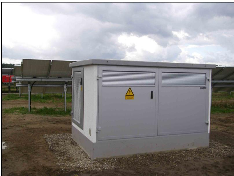
**Abb. 27:** Beispiel für einen Transformator, der den Wechselstrom von 400 V auf 20 KV hochtransformiert, hier Solarpark Kremmen.
