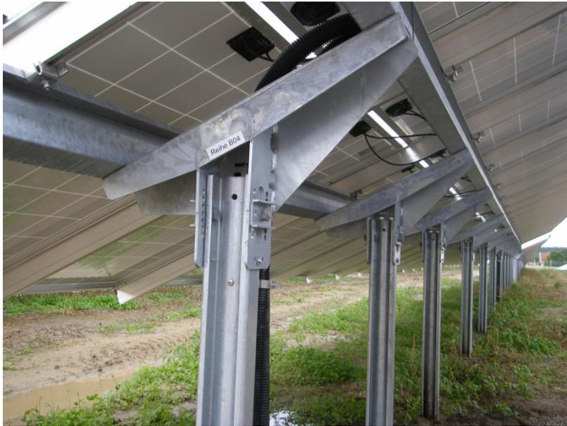
**Abb. 24:** Unterkonstruktion der Photovoltaik-Module mit nur einer Mittelstütze, hier Solarpark Kremmen. (Foto RIK: P7120001)
