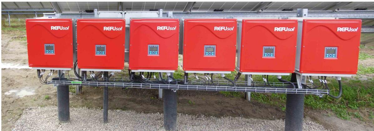
**Abb. 26:** Beispiel für eine unter den Modultischen stehende Wechselrichteranlage aus sechs einzelnen Wechselrichtern, hier Solarpark Kremmen.
