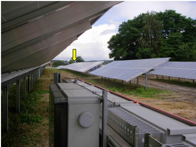
**Abb. 29:** Beispiel aus dem Solarpark Kremmen für die höhenmäßige Anpassung der Modulreihen an das Gelände. Der Pfeil zeigt eine Verwerfung, die für die Funktionstüchtigkeit der Photovoltaikmodule ohne Bedeutung ist.
