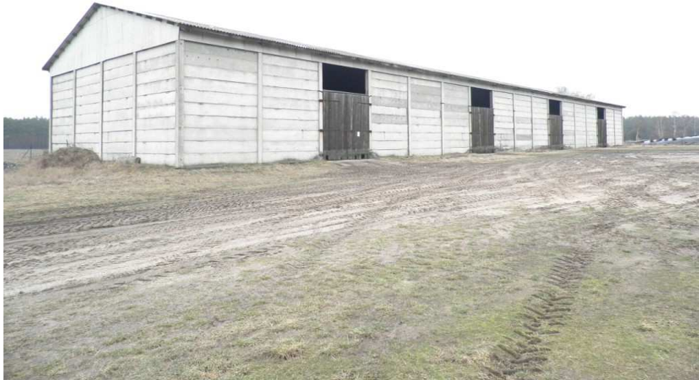
Bild 5: Blick von Westen auf die Lagerhalle im Zentrum des Plangebiets
