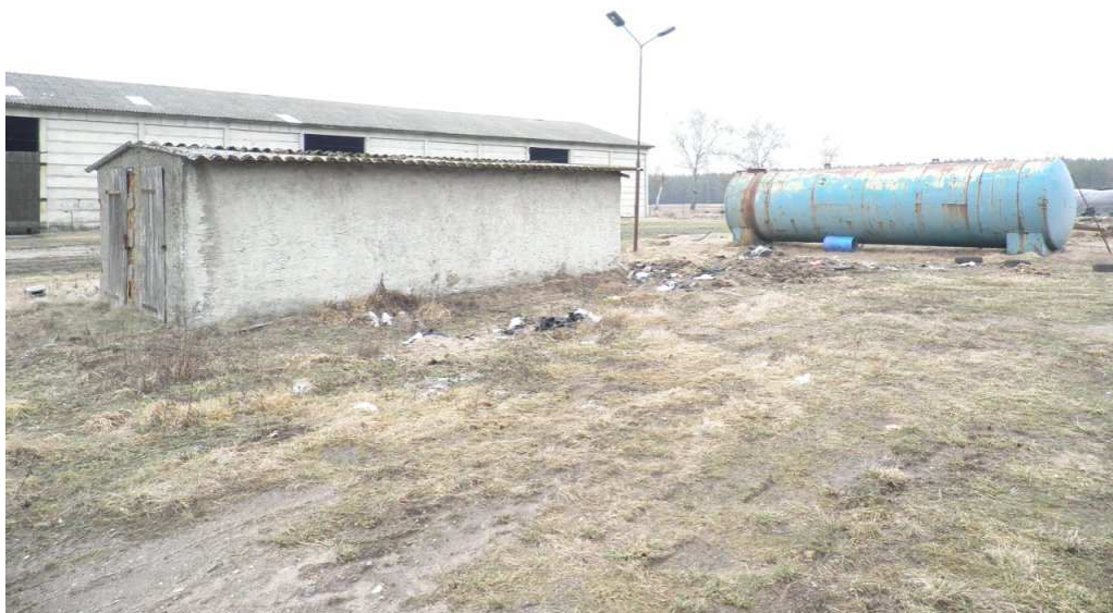
Bild 6: Schaltheus und Flüssigdüngerlager aus Stahltanks im Zentrum des Plangebiets bzw. Baufeldes der PVA
