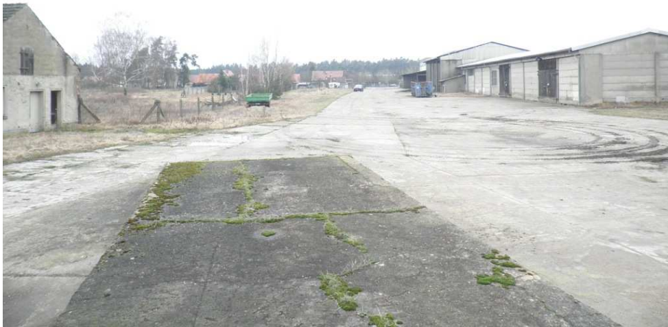
Bild 1: Versiegelte Gebäude, Verkehrs- und Betriebsflächen im Westteil des Plangebiets bzw. hier Baufeld des Betriebshofes (Blick von Süden nach Norden)
