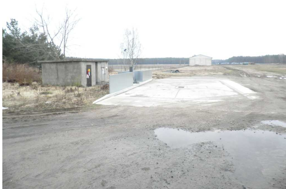
Bild 4: Neue Tankstelle an der nördlichen Plangebietsgrenze (Blick von Westen nach Osten)
