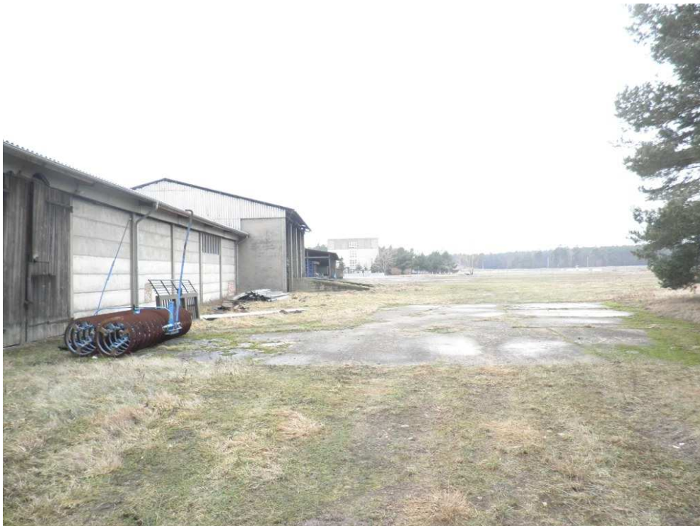
Bild 2: Versiegelte Gebäude, Verkehrs- und Betriebsflächen östlich Gebäude der Werkstatt mit Nebengebäude im Westteil des Plangebiets (Blick von Süden nach Norden)
